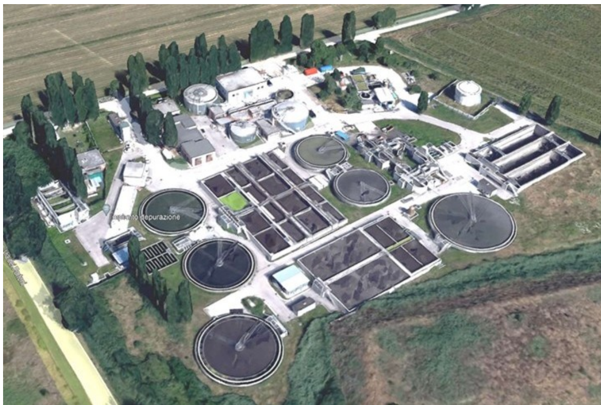
Impianto di depurazione liquami
