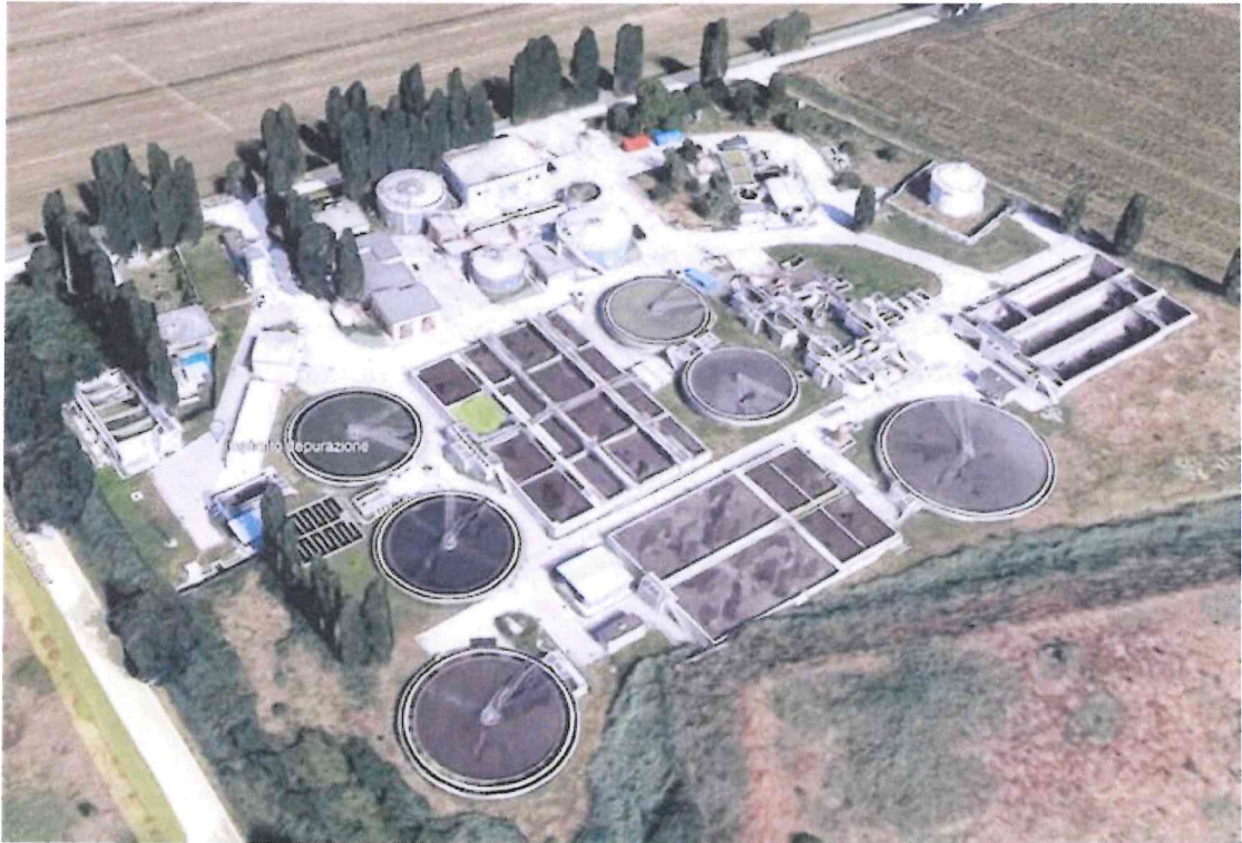
Impianto di depurazione liquami
