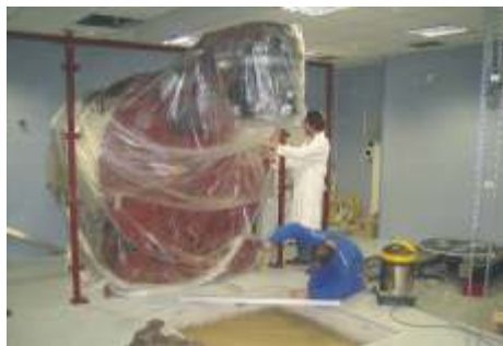
Installazione del nuovo macchinario
